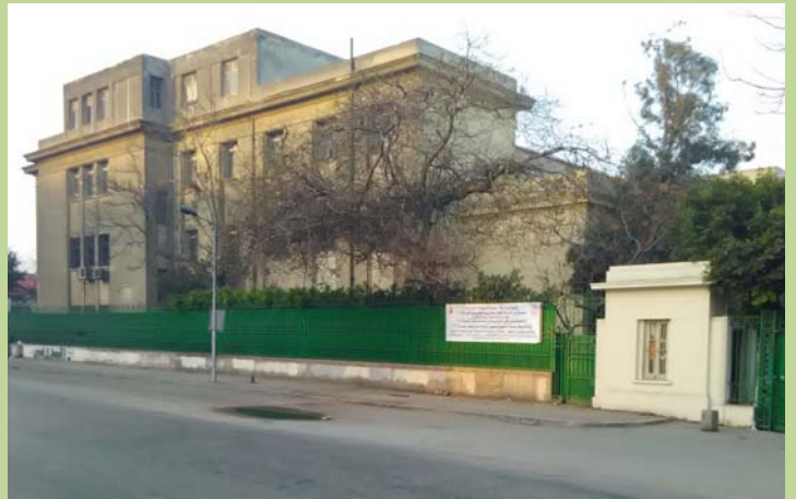
مبنى قسم الهندسة الكيميائية قبل البدء فى أعمال الدهانات الخارجية
