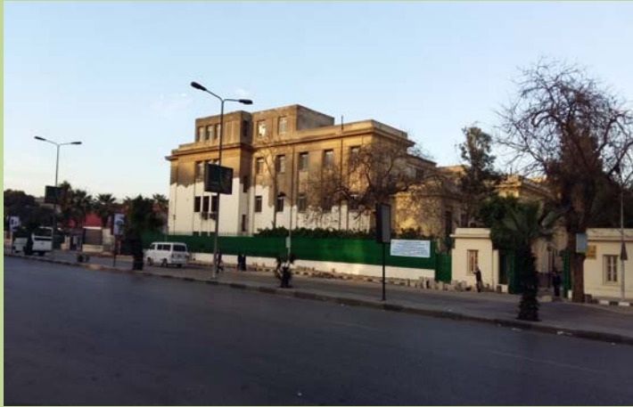
مبنى قسم الهندسة الكيميائية اثناء أعمال الدهانات الخارجية
