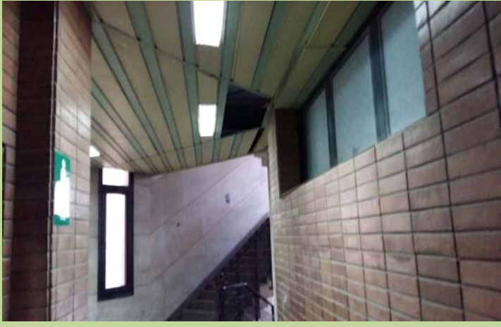
سقف الدور الرابع بمبنى ميكانيكا الجديد قبل أعمال الإحلال والتجديد
