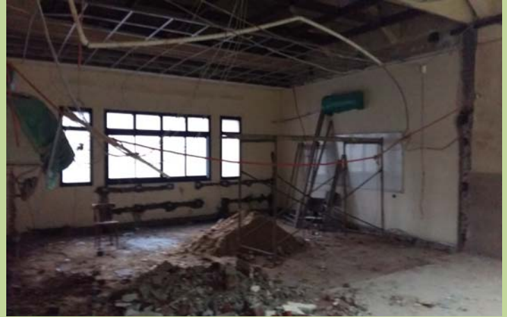
معمل نادى تكنولوجيا المعلومات اثناء أعمال الإحلال والتجديد
