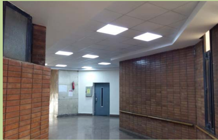
سقف الدور الرابع بمبنى ميكانيكا الجديد بعد أعمال الإحلال والتجديد
