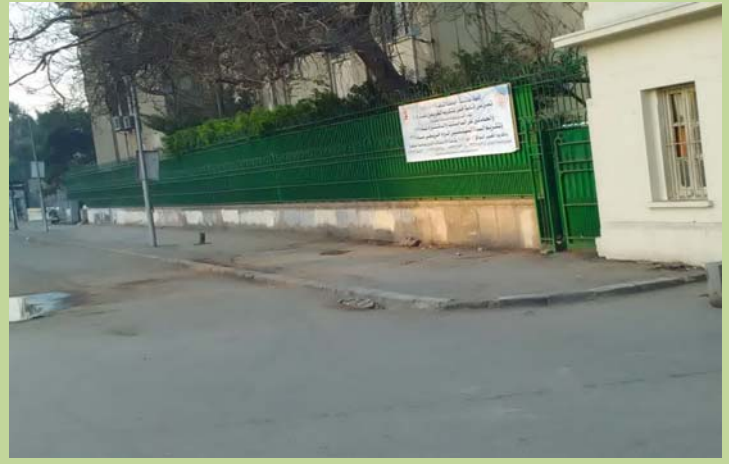
الرصيف امام مبنى قسم الهندسة الكيميائية قبل أعمال الإحلال والتجديد
