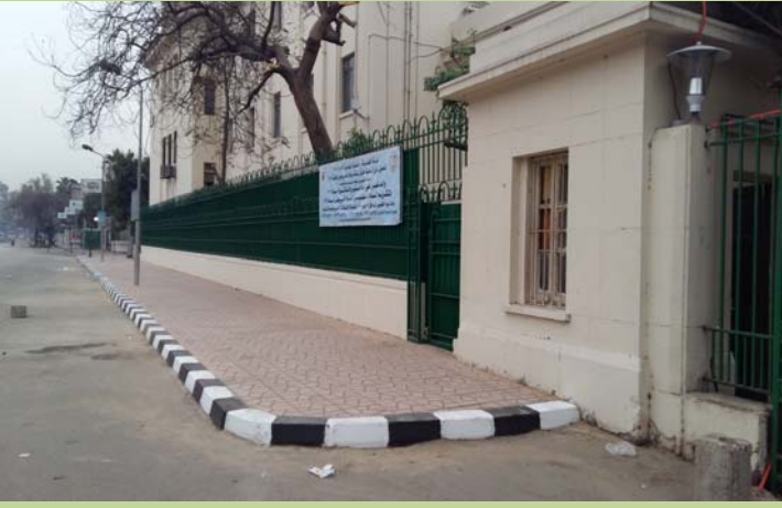
الرصيف امام مبنى قسم الهندسة الكيميائية بعد أعمال الإحلال والتجديد
