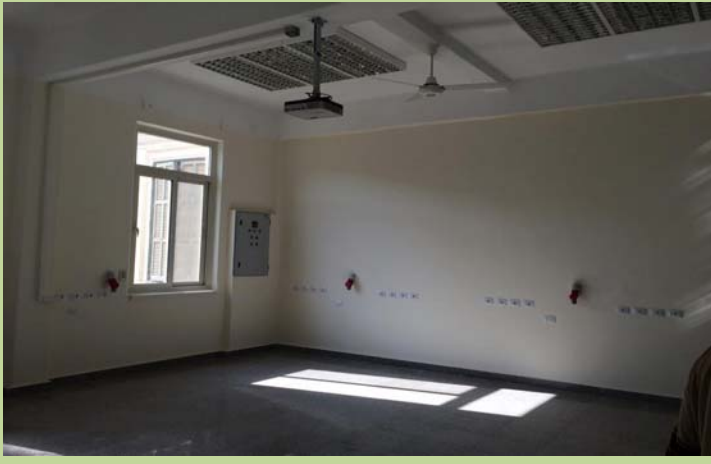
معمل الكترولنيات القوى الكهربية بمبنى المكتبة.
