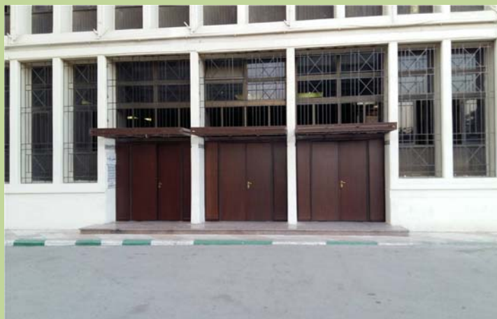
أبواب المدخل الرئيسي لمبنى عمارة بعد الاحلال والتجديد
