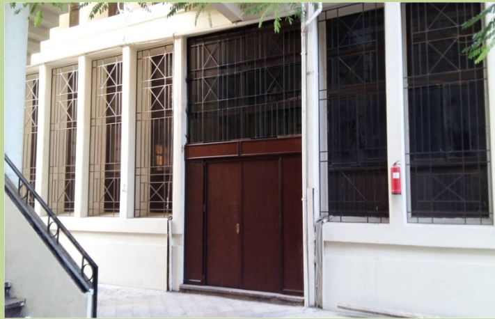
أبواب وشبابيك الدور الأرضى - الجهة الشرقية مبنى عمارة بعد الاحلال والتجديد
