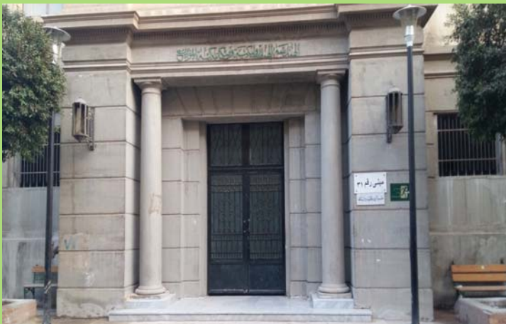
المدخل الرئيسي لمبنى الري والهيدروليكا بعد أعمال الإحلال والتجديد
