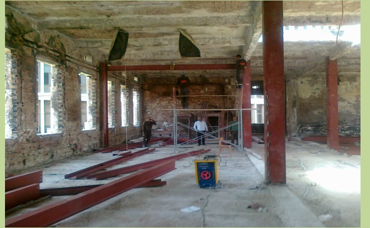
مراحل تركيب المنشأ المعدني بالدور الثاني بمبنى الإدارة
