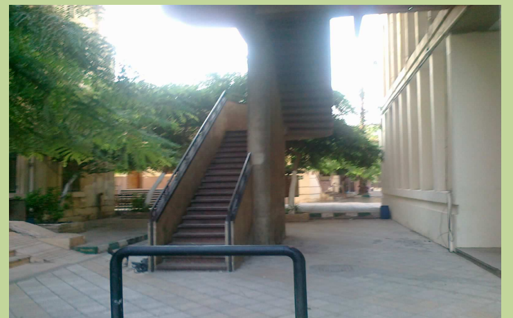
السور المعدني لسلم الطوارئ بمبنى عمارة
