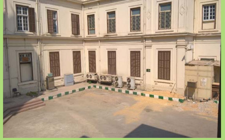
الموقع الجديد لتجميع صناديق القمامة قبل البدء في أعمال إنشاء الوحدة
