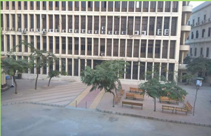
المنطقة خلف مبنى عمارة بعد أعمال الإحلال والتجديد
