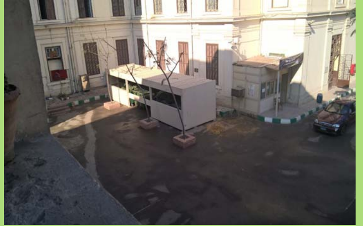
وحدة تجميع صناديق القمامة خلف مبنى مكتبة الكلية
