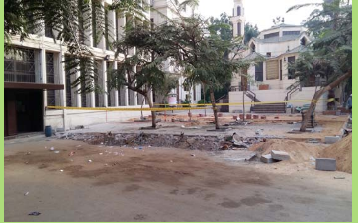
المنطقة خلف مبنى عمارة أثناء أعمال التطوير
