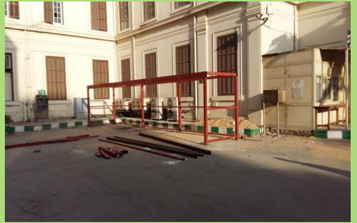
وحدة تجميع صناديق القمامة أثناء الإنشاء
