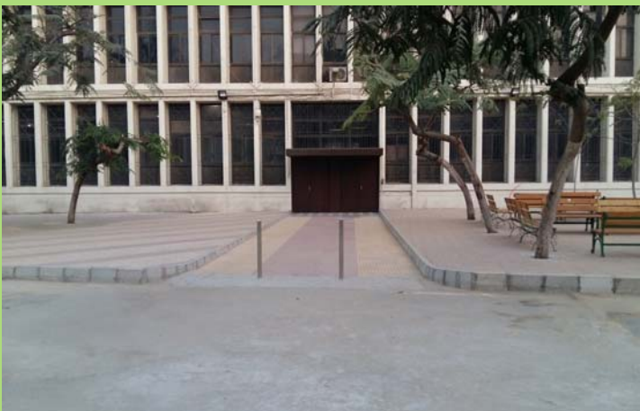
ممر المدخل الجنوبي لمبنى عمارة بعد الإحلال والتجديد
